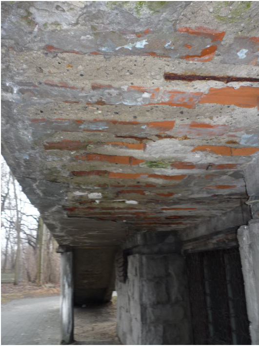
Rys. 7. Odślonięte zbrojenie.
