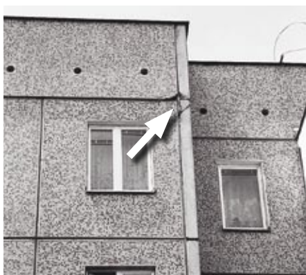
Spękana płyta trójwarstwowa wraz z warstwą fakturową
