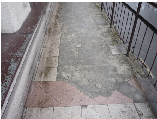
Rys. 21. Ubytki i pęknięcia.
