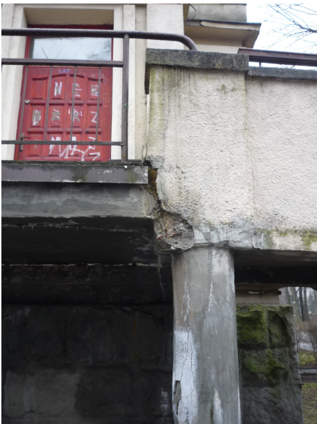
Rys. 20. Ubytki w tynku
