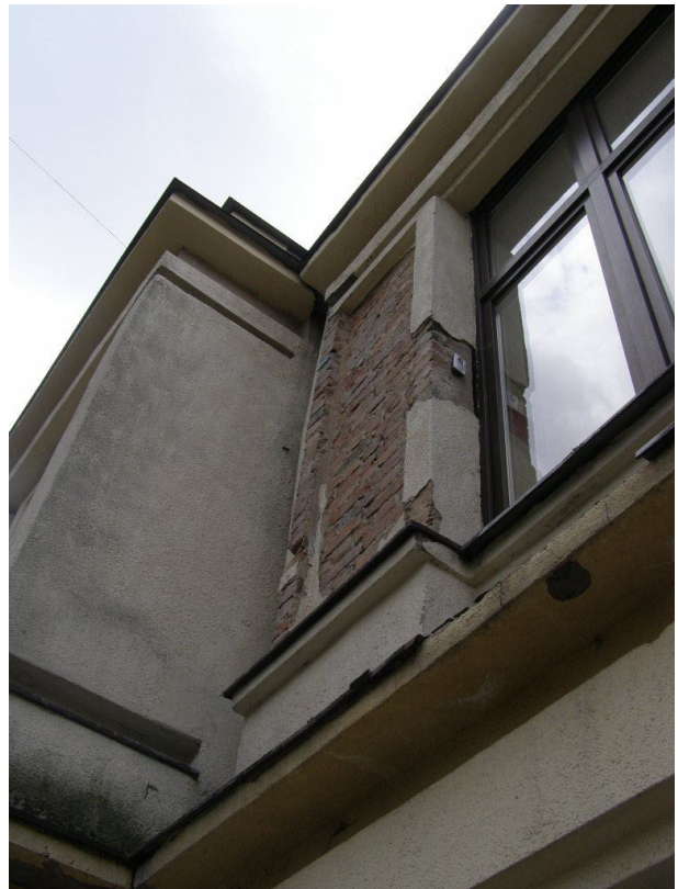
Rys. 17. Ubytki w tynku
