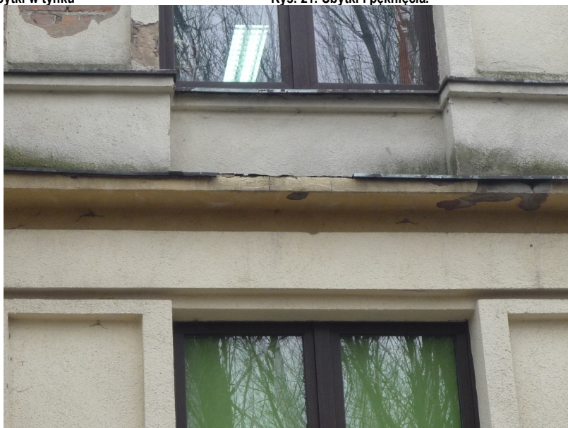
Rys. 20. Ubytki w tynku
