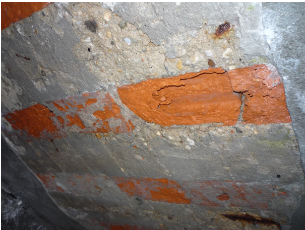
Rys. 9. Ubytki w wypełnieniu..
