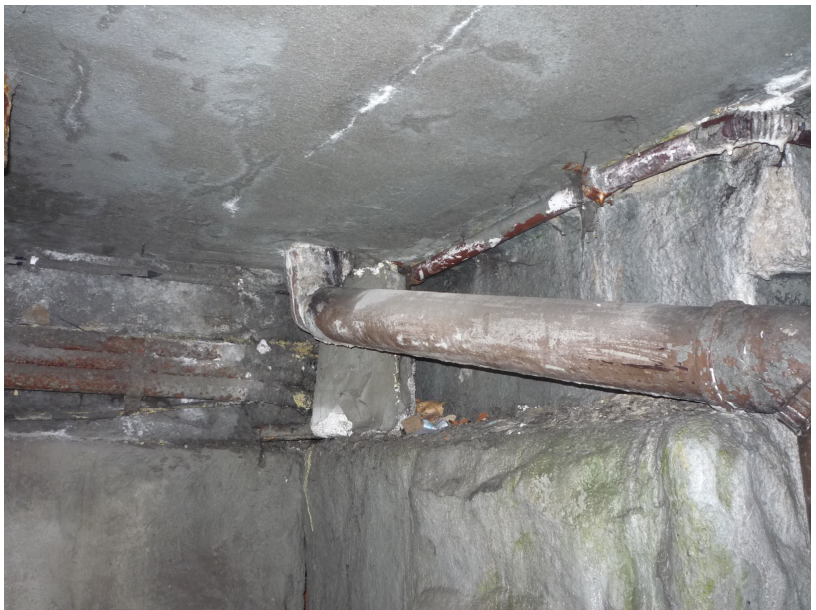
Rys. 19. Rura spustowa
