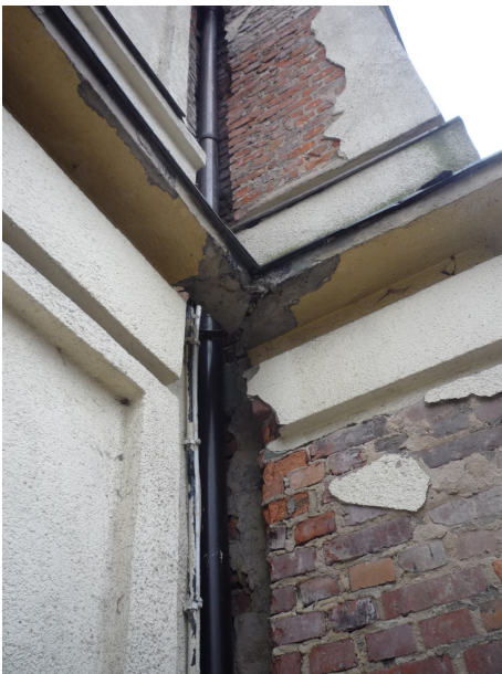
Rys. 18. Ubytki w tynku
