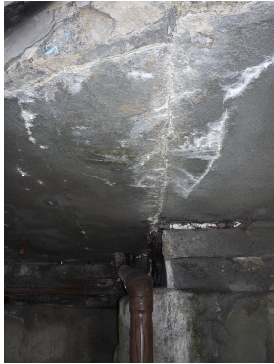
Rys. 8. Rysy i pęknięcia płyty.
