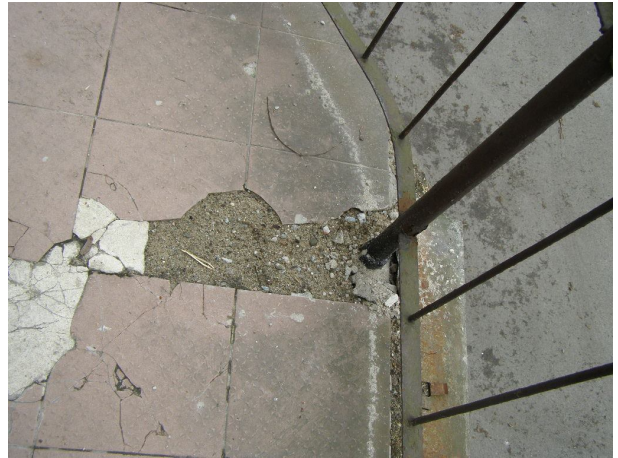
Rys. 15. Pęknięcia i ubytki płytek.
