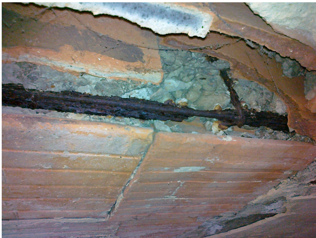
Zbrojenie przez korozję i uwadnianie tlenków żelaza pęcznieje. Pręty utraciły około 50% przekroju.
