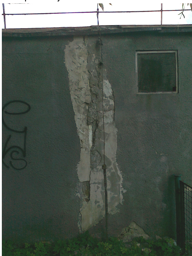
Dylatacja między segmentami jest zamknięta sztywnym materiałem.
