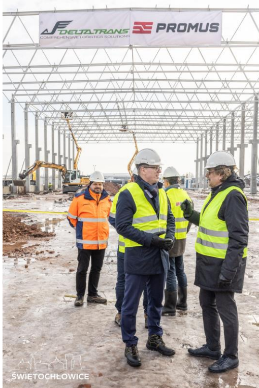
Wizyta na placu budowy Delta Trans
