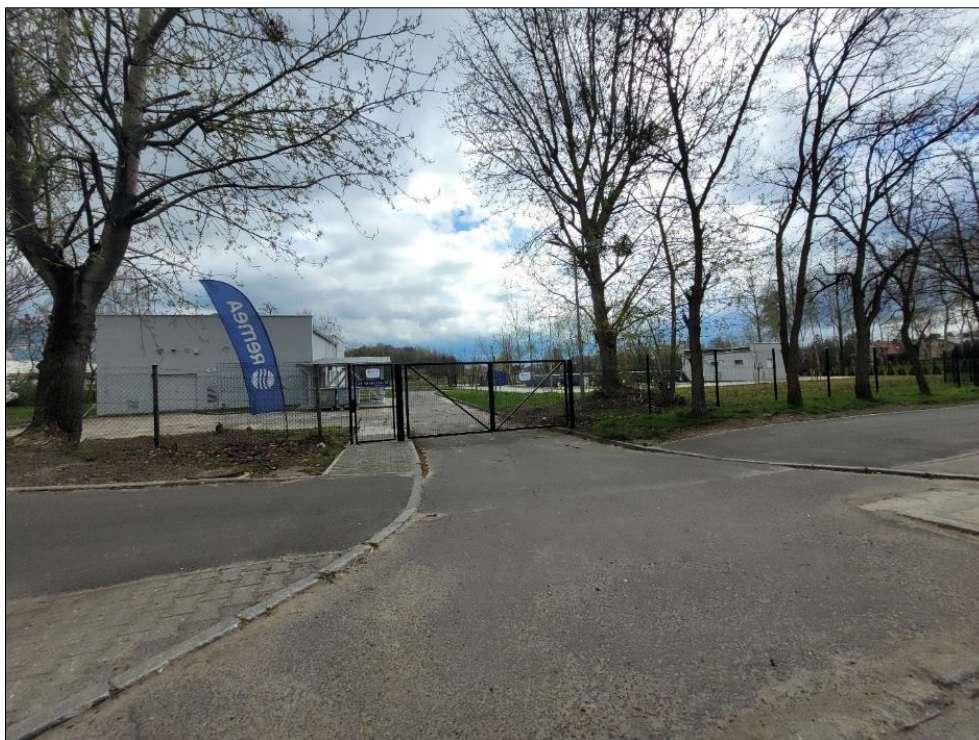
FOTOGRAFIA 24. PRZEPOMPOWNIA WODY ZE STAWU KALINA PRZY UL. WIŚNIOWEJ
