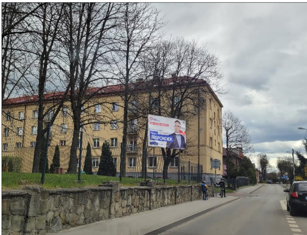
FOTOGRAFIA 14. ZABUDOWA MIESZKANIOWA WIELORODZINNA PRZY UL. NOWEJ
