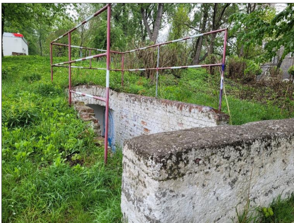
FOTOGRAFIA 17. SZCZELINA PRZECIWOLOTNICA W REJONIE KOŚCIOŁA PRZY UL. KARDYNAŁA S. WYSZYŃSKIEGO I UL. NOWEJ
