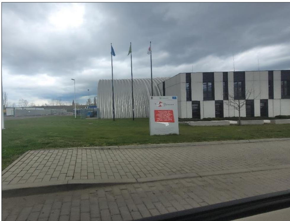
FOTOGRAFIA 12. WIDOK NA INVESTEKO S.A. W PÓŁNOCNEJ CZĘŚCI OBSZARU OPRACOWANIA
