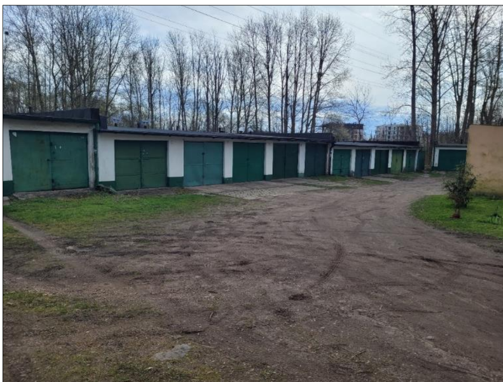
FOTOGRAFIA 5. TEREN GARAŻY W REJONIE UL. ŚLĄSKIEJ
