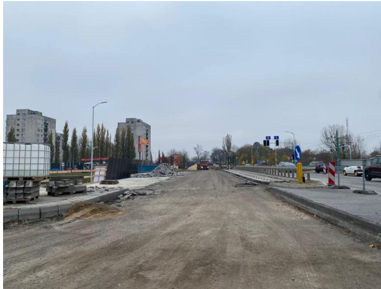
Wizyta gospodarska na remontowanej ul. Bytomskiej
