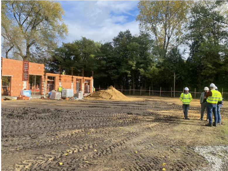
Wizyta gospodarska na terenie budowy przedszkola i klubu dziecięcego w Lipinach
