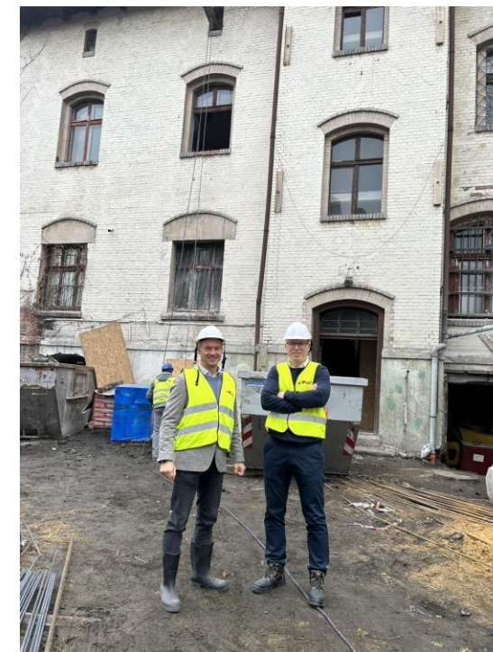
Wizyta gospodarska w remontowanym budynku Centrum Kultury Śląskiej „Grota”
