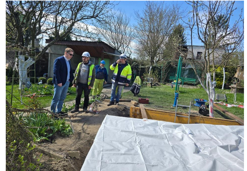
Wizyta w miejscu usuwania awarii sieci ciepłowniczej przy stawie Foryśka
