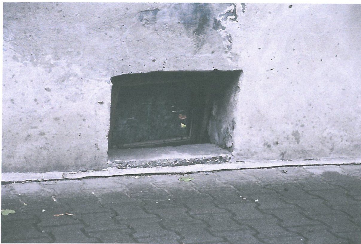
Jedno z okien piwnicznych
